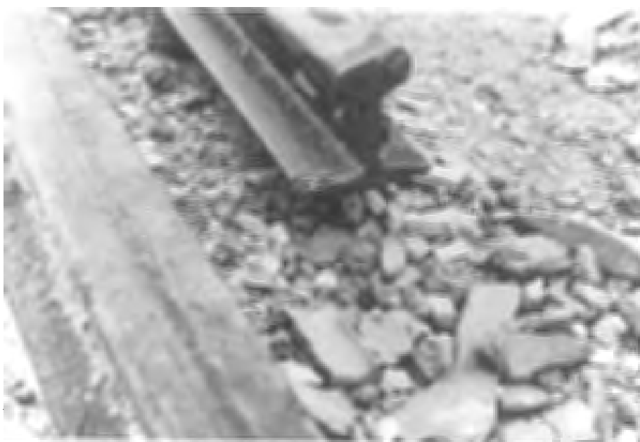
FIG. 31. PÅLSPETSEN PÅ PÅLE 5 EFTER SLAGNING OCH UPPDRAKNING
